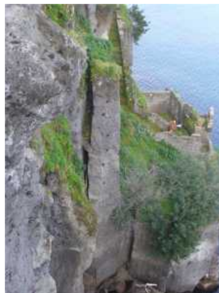
Fig 8. Pinnacolo di roccia in posizione di ribaltamento già oggetto di intervento con
