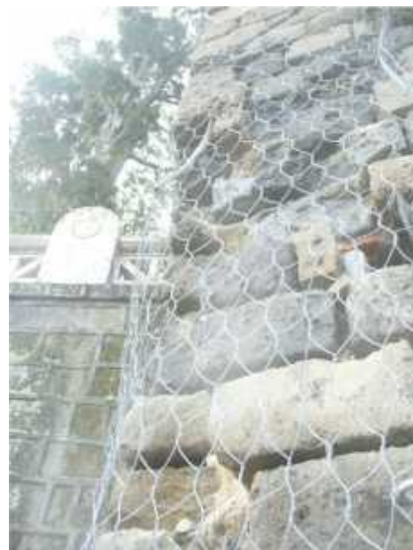
Fig 7. muro disarticolato con pannello di
